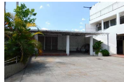
GALERA CASA ANEXA
