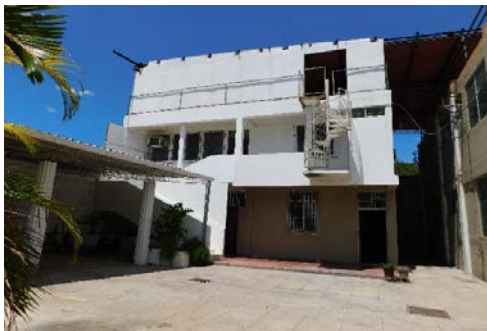
FACHADA CASA ANEXA
