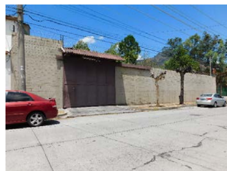
ENTRADA PORTÓN 93 AVENIDA
