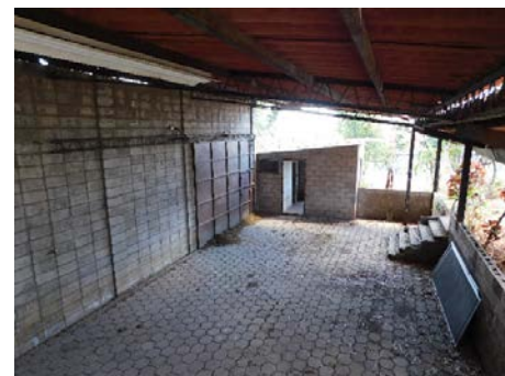
PARQUEO Y CASETA (ADICIONAL)
